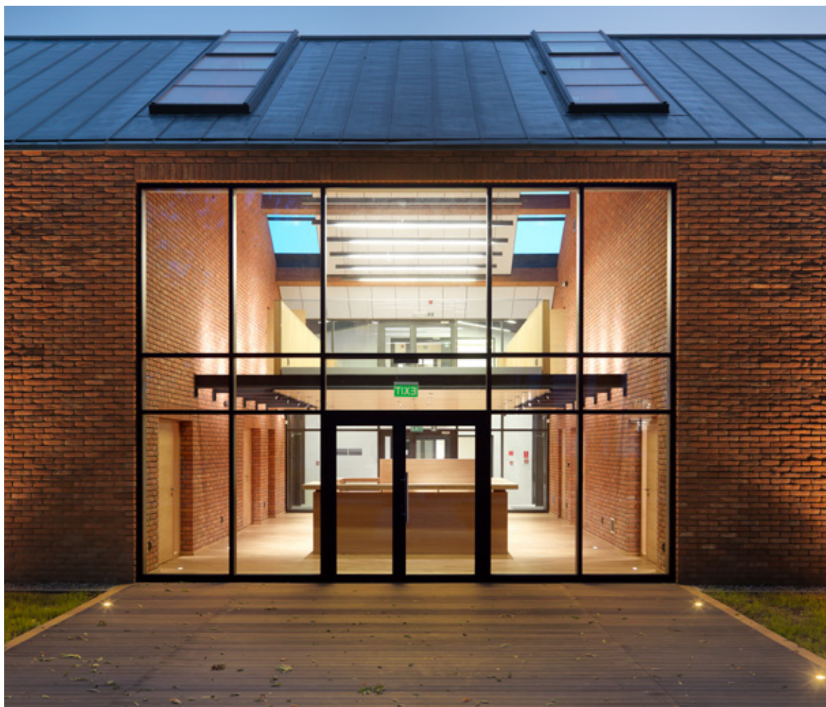
Casimir Pulaski Museum, Warka, Poland, Proj. Bulanda, Mucha architektki Muzeum im. Kazimierza Pułaskiego w Warce-Winiarach, Polska, Proj. Bulanda, Mucha architektki
